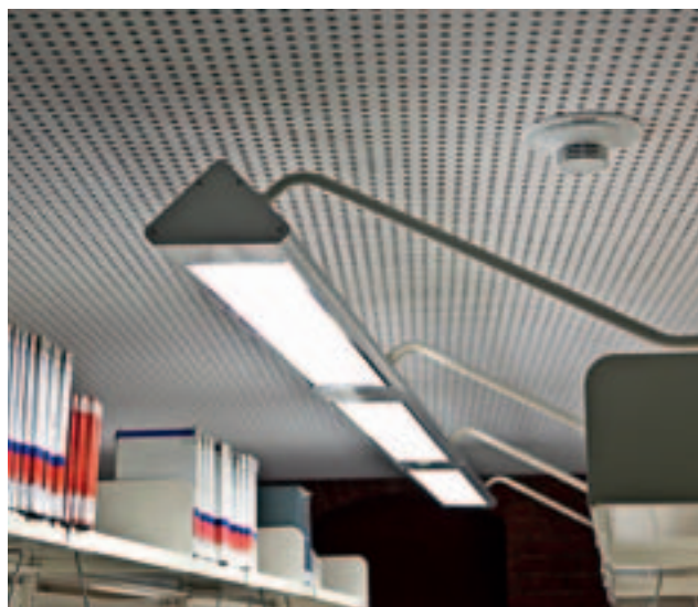
Punktförmige Mehrfachsensormelder (oben) überwachen die Bibliothek, die terrassenförmig in den Innenhof des denkmalgeschützten Hauptgebäudes (ganz oben) gebaut wurde.
